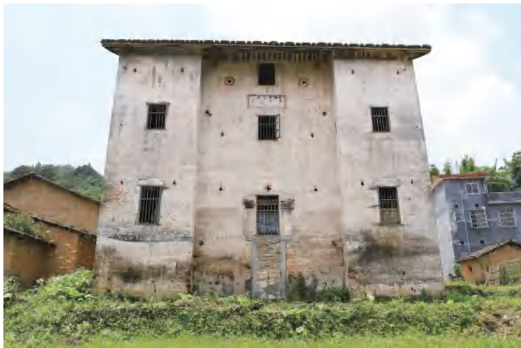
▲ 金山村梅坑大楼旧址
